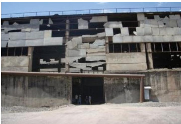
График0-1:Разрушение строения со значительным повреждением асбестовых плит
